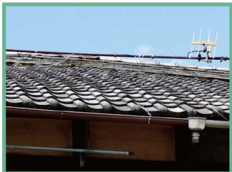
瓦や雨どいなど屋根まわりを確認します。築20年超えの物件は、予防措置として「屋根の水仕舞い」の対策も行うのがオススメです。
