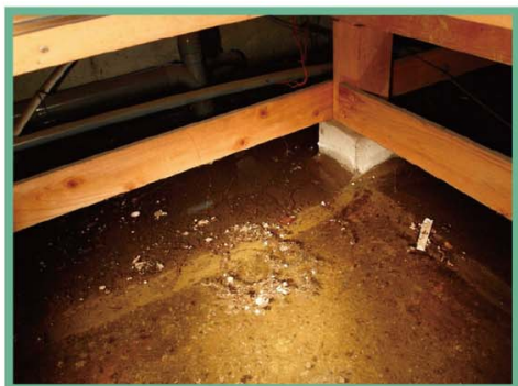
室内に入って、点検口などから床下や屋根裏を確認します。この時に基礎の状態やシロアリ被害の有無などもチェックします。
