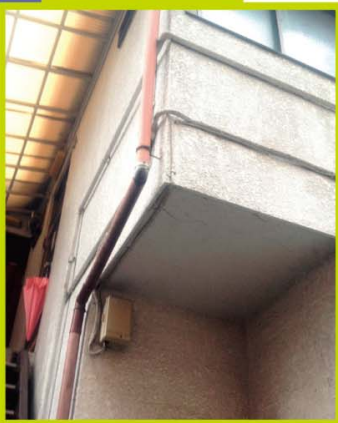
一棟アパート
