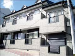
宮城県仙台市にある窓野オーナーのアパート
